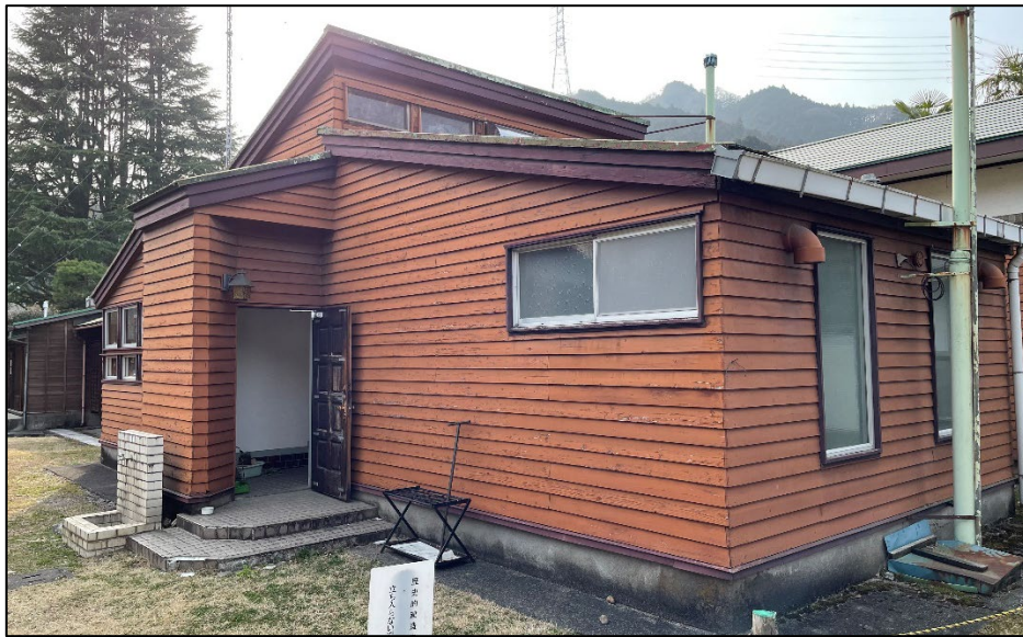
〈青山旧館写真〉【台所棟・お手洗い】
