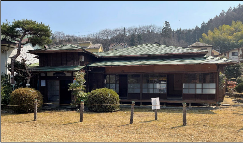
〈青山旧館写真〉【和館棟】
